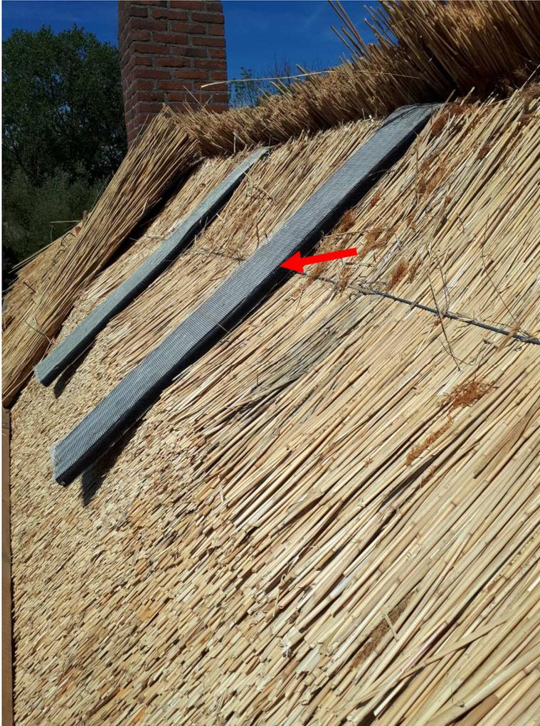
**8. Über die Firstmitte sollte vorsichtshalber ein kleines Stück UV-beständige Dichtungsbahn positioniert werden (ca. 33 x 40 cm o.ä.)**
