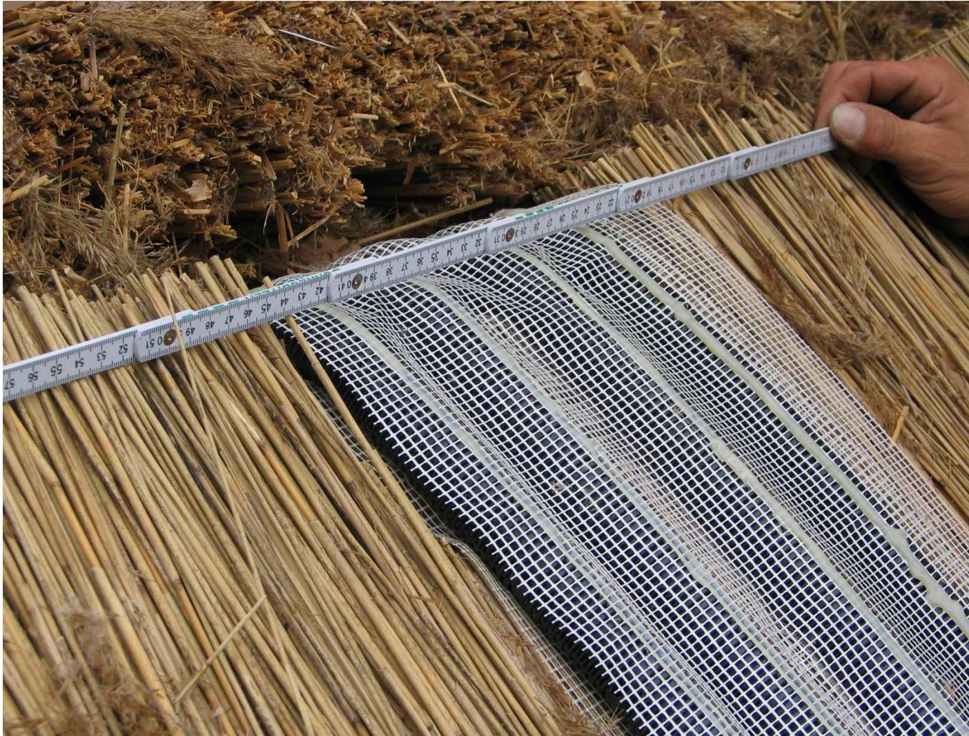
**7. Die Röhren – Lüfter – Matte sollte vor der Überdeckung mit dem REET – First – Gebinde an der Stange etwas fixiert werden**
