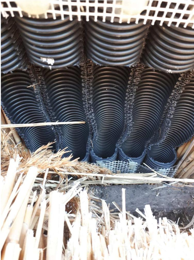
**5. Bei einseitiger First - Entlüftung wird das kurze Teilstück geknickt und in die Entlüftungsöffnung gesteckt**
