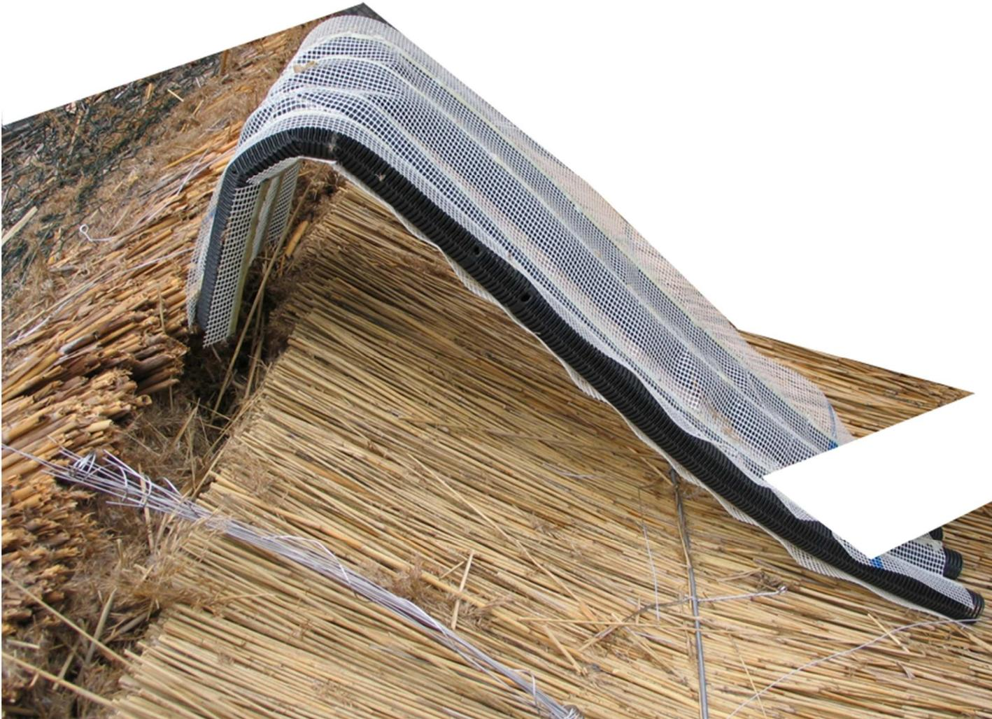
**6. Die obere REET – First – Kante und die Oberfläche der Röhren – Lüfter – Matte sollten möglichst in einer Linie liegen**
